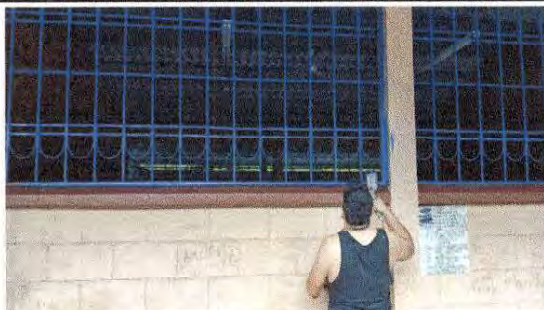
FOTO 7: Mantenimiento a balcones de metal
