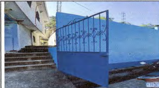
FOTO 14: Mantenimiento a portones de metal
