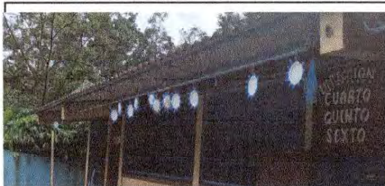
FOTO 2: Sustitución de canal de metal incluye soporte de metal
