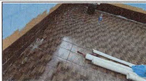
FOTO 8: Sustitución de piso de cemento líquido por piso cerámico
