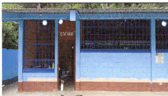
FOTO 9: Pintura en muros exteriores e interiores
