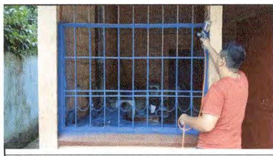
FOTO 11: Mantenimiento a balcones de metal
