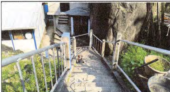
FOTO 13: Sustrucción de barandas de metal. Por tubo hg galvanizado
