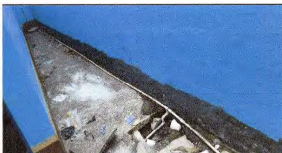
FOTO 3: Sustitución de tubería línea principal
